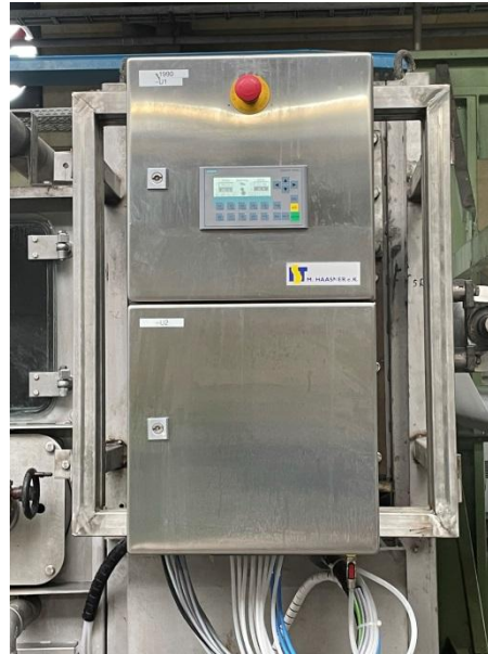
nach dem Umbau „IST“
